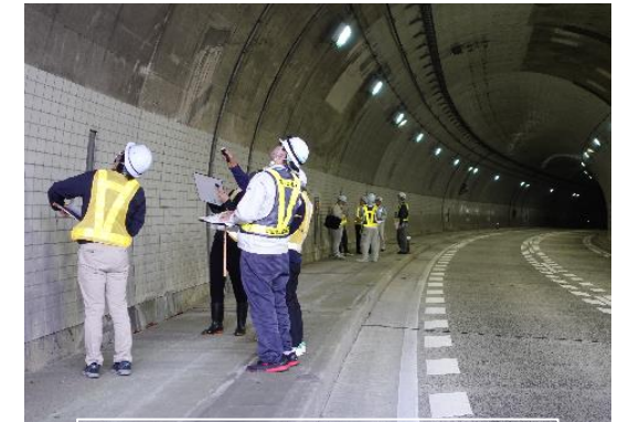
トンネル内にて点検実習
